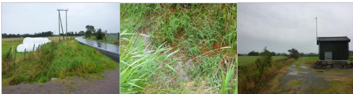
Figur 6.25: T.v.: Kanalen mottar overflateavrenning fra vei (og potensielt fra siloballer). Midten og t.h.: Vannkvaliteten på kanalen som munner ut ved nødpumpestasjonen er ikke god.
