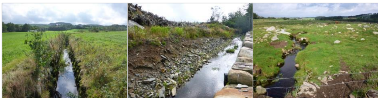
Figur 6.20: T.v.: En kanalisert sidebekk krysser fulldyrka mark vest for Skarberget Grustak. Midten: Det har vært stormfelling i skogholtet i midten av kanalen, og deler av bekken er nylig steinsatt. T.h.: Sidebekken går gjennom et fuktig beiteområde ned mot Tverråna.
