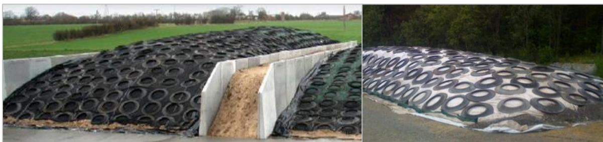
Figur 4.11: Plansilo med støpte betongvegger (t.v.) har mindre utslippsrisiko enn plansiloer som anlegges på bakken (t.h.).
