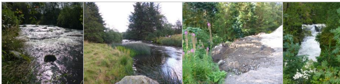
Figur 6.40: T.v.: Steiner, terskler og bukter er attraktivt for fisken i elva. Midten: Fyllingsmasser ned mot skogen ved elva. T.h.: Fotlandsfossen.
