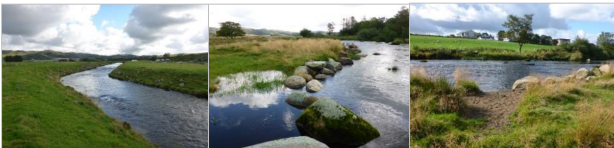
Figur 6.39: T.v.: Elva ble senket og kanalisert på 70-tallet, et tiltak mot flom. Midten og t.h.: Deler av elva er sårbar for flom og erosjon. Det er lite vegetasjonssone langs elvebredden.
