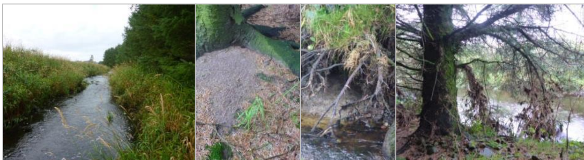
Figur 6.27: T.v.: Elvebredden er beskyttet mot flom av den vegetasjonsrike jordvollen som går langs marka. Midten og t.h.: Skogen på vestsiden av åna er utsatt for sedimentering og erosjon, og det er tydelig at vannhøyden stiger drastisk i dette området.
