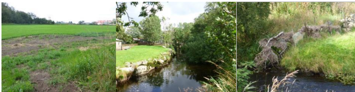
Figur 6.23: T.v.: Planering eller drenering langs elvekanten. Midten og t.h.: Langs en kanalisert del av bekken ligger bygninger nært elvekanten. Området er utsatt for flom og er ikke beskyttet av noen vegetasjonssone.
