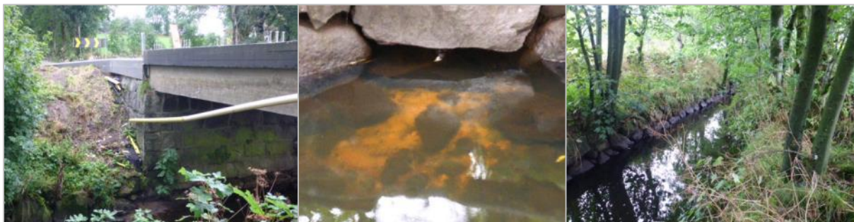
Figur 6.7: Vannet fra Mossigebekken og Tjensvollbekken ledes under ei bro på Garborgveien (t.v.), og inn i en kanal (t.h.). På dette strekket ble det observert sementrester i vannet, avrenning fra markdren (midten), samt hageplanter som rips og stikkelsbær.
